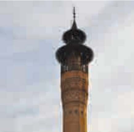
Resim-3 Ulu Camii Köşk Minare
