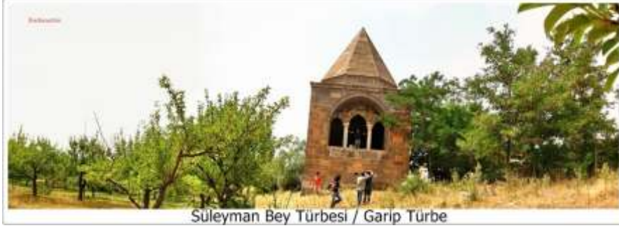
Süleyman Bey Türbesi / Garip Türbe
